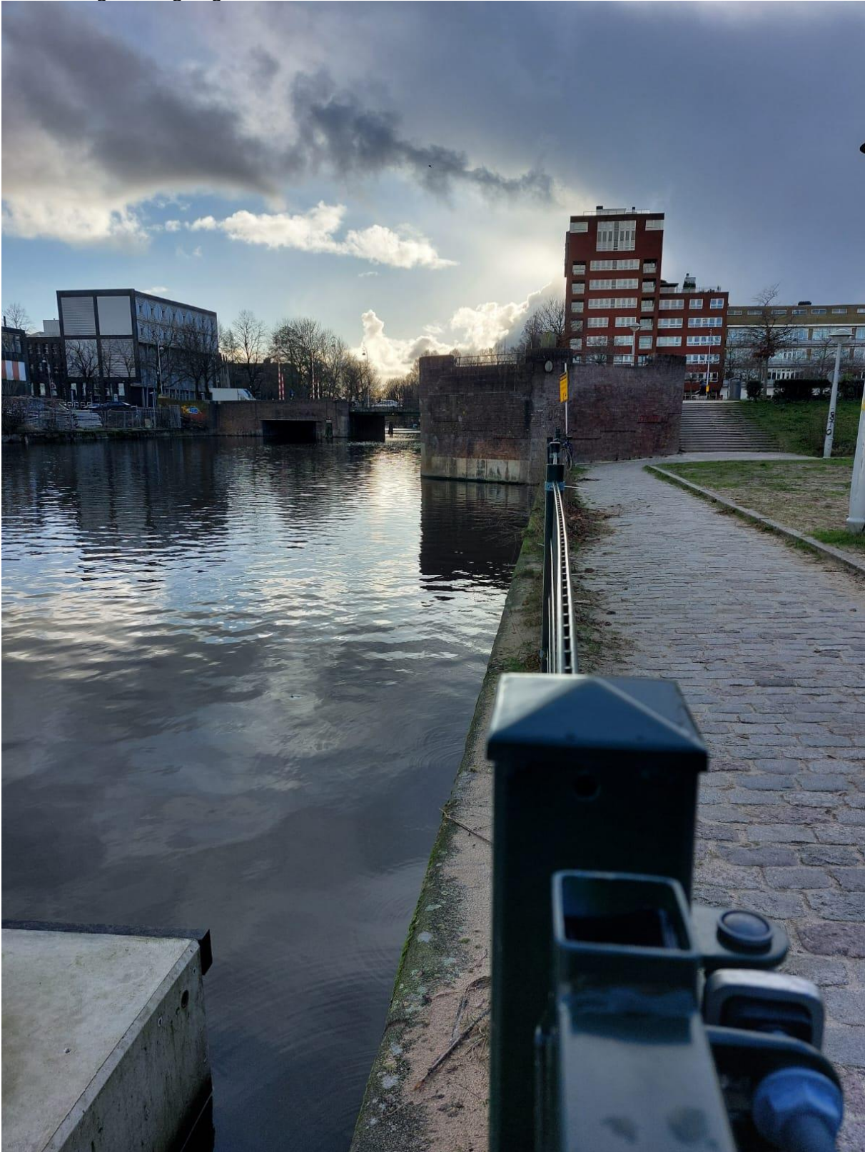
Bijlage 1: aan de kade van de speeltuin is nog heel veel ruimte over en daar zijn al voorzieningen aangelegd.
